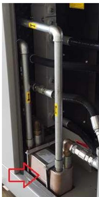
Рис. 1 Пример теплообменника, устанавливаемого на компрессоре
